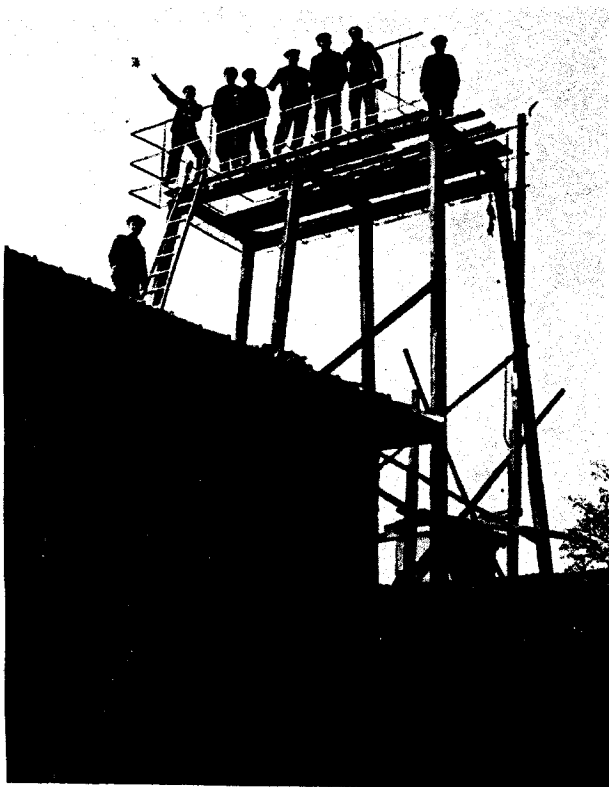
1928. Ηλεκτρική Σουφλίου. Κατασκευή ικρίωματος για την τοποθέτηση δεξαμενής νερού στην οδό Ερμού.
